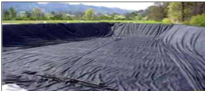
Figure 03 : Photo d'une alvéole de CET couverte par une géo-membrane (Ets travaux Géomembrane, 2018).
