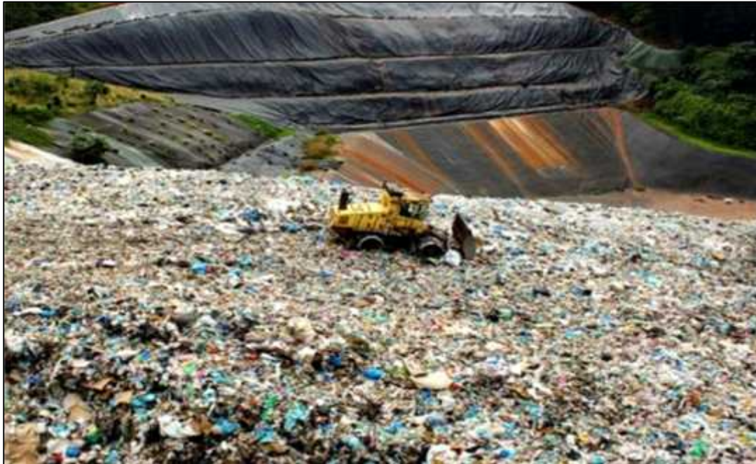
Figure 01: Photo d'une alvéole de CET en cours de remplissage (Siouane, 2018).
